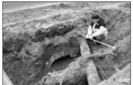
Jean Roefstra bij het gemetselde bakstenen gewelf.
