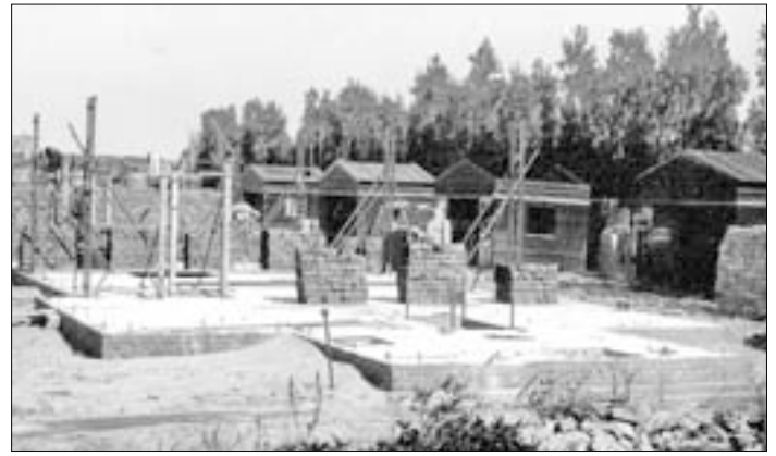
Herbouw Vinkenbaanwoningen aan de Staalhaven. Het is 30 augustus 1948.
