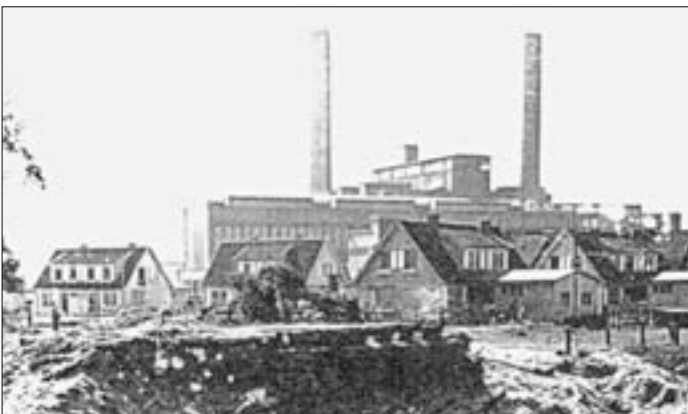
Hoek Wenckebachstraat-Staalhavenweg tijdens het graven van de Staalhaven in 1937
