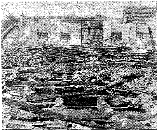
Dit was over van het pakhuis van de firma Bos & Co na de brand.
